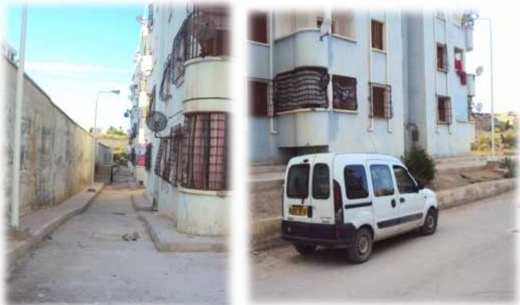
Figure 59: l'espace devant l'entrée du bâtiment.
