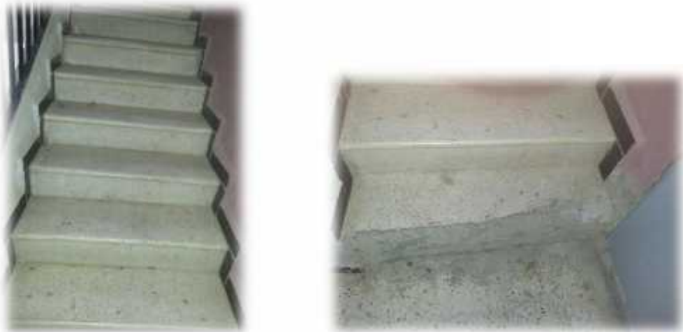
Figure 58: la cage d'escalier du 3eme cas d'étude.
