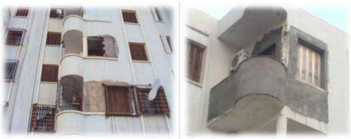
Figure 61: Des modifications au niveau des façades.
