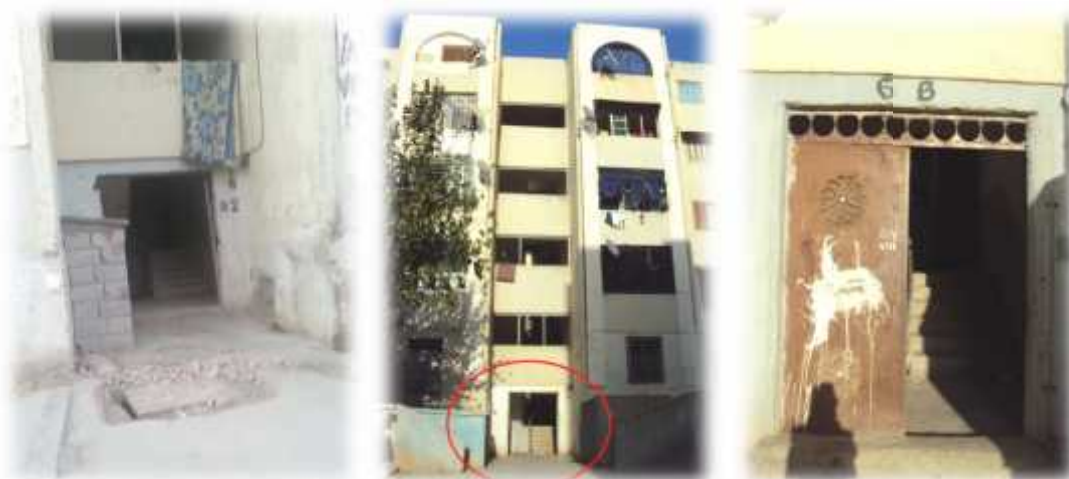
Figure 25: L'entrée des bâtiments.
