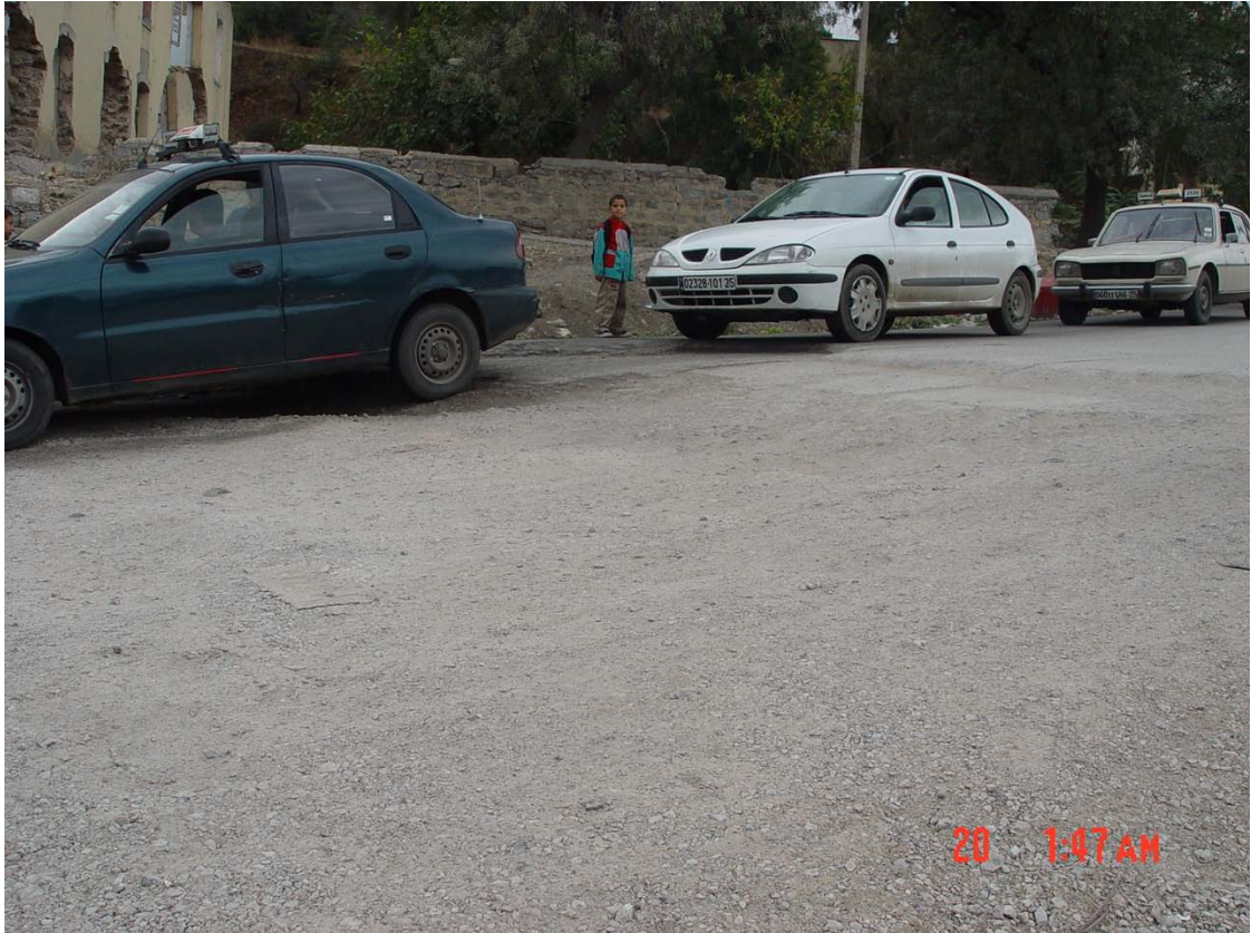
Fig. 35 : Avenue Rahmani Achour : un glissement sur la voie remblayé par du tout venant.
