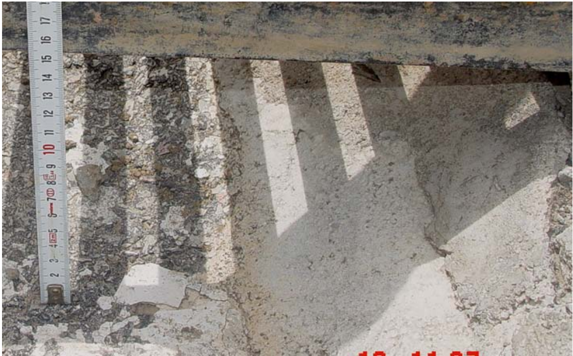
Fig. 34 b : Le déplacement est vertical de 15. cm ; la faille a été caché par une autre couche de mortier au ciment.
