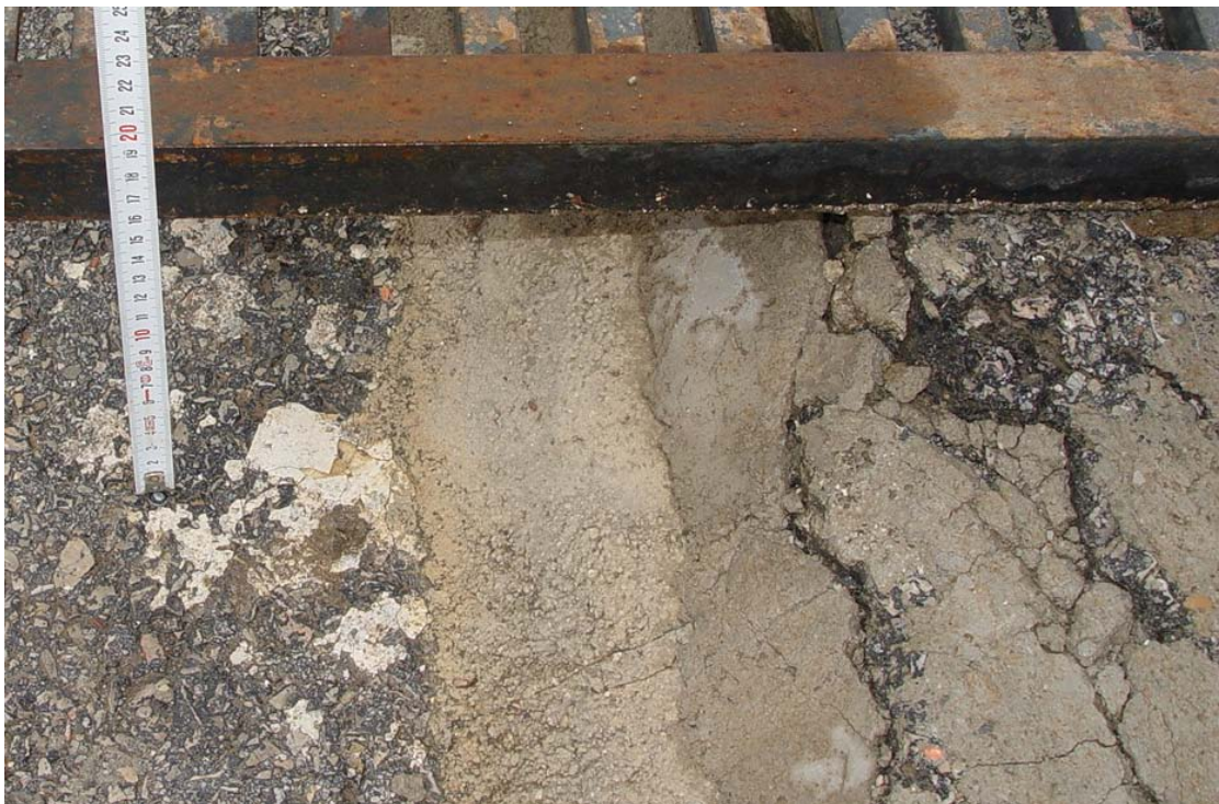
Fig. 34c : Le déplacement est verticale de 16.5 cm, la faille ne s'arrête pas et le glissement s'enfonce encore plus.
