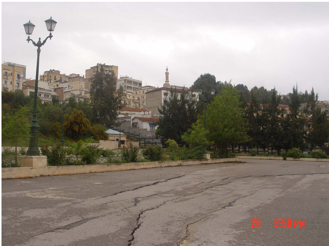
Fig. 34 d : En premier plan, le prolongement du glissement d'où l'on remarque le remplissage des failles qui ne cessent de s'arrêter ; en second plan le minaret de cité Belle Vue
