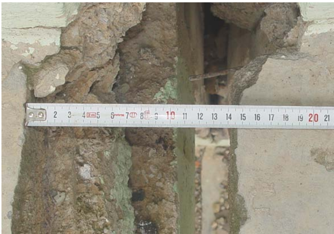
Fig. 30 b : Le joint sec de la bâtisse qui s'élargit encore plus (15 cm), soit un élargissement de 4cm en plus en 18 mois
