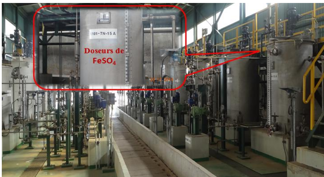
Figure 13: Photographie montrant le 1 er traitement par le sulfate de fer ( \text{FeSO}_4 ) pour provoquer la floculation (ETP-2).
