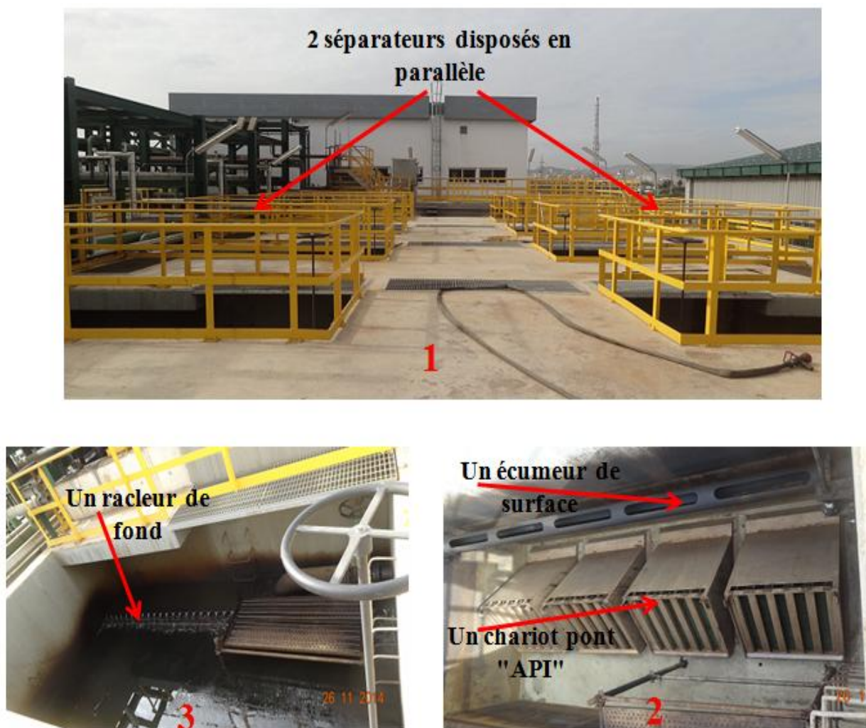
Figure 12: Photographie montrant le bassin de traitement des eaux polluées par les hydrocarbures (ETP-2) de la raffinerie de Skikda: 1-Séparateurs en parallèle vu d'en haut, 2- Un séparateur vide, 3- Un bassin montrant le racleur de fond.
