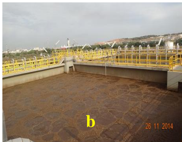
Figure 15: Photographies montrant différents angles du bassin où se déroule le traitement biologique a: bassin biologique montrant les turbines d'air par les flèches rouges. b: vue intégrale du bassin biologique.
