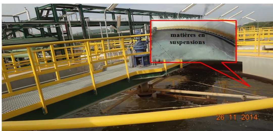
Figure 14: Photographie montrant le bassin de floculation de la station d'épuration des effluents (ETP-2) de la raffinerie de Skikda.
