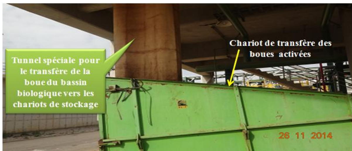
Figure 17: Photographie montrant le système d'évacuation des boues en excès (ETP2).
