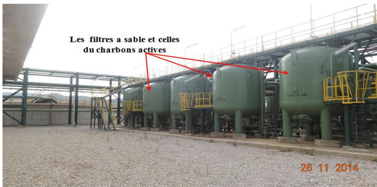
Figure 18: Photographie montrant les filtres à sable -(ETP-2).
