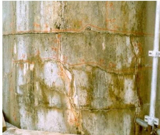
**Figure I.20-** Attaque sulfatique interne
