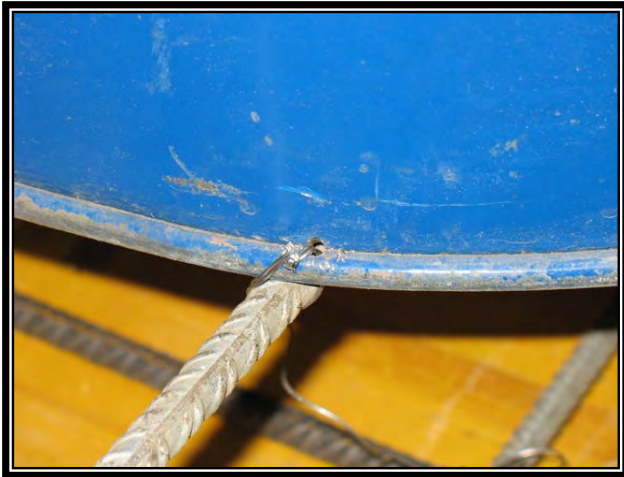
Fig. 2.6 – fixation du baril à l'armature par du fil de fer
