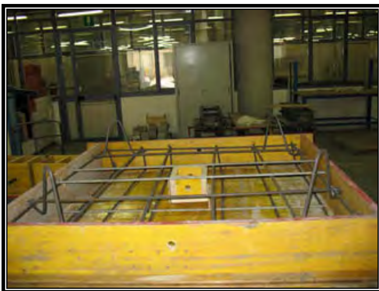
Fig. 2.3 –l'armature complète
