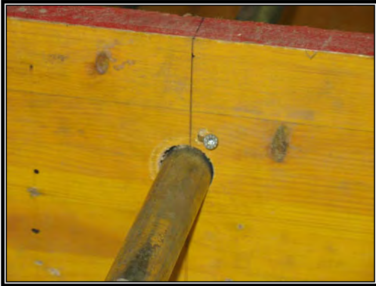
Fig. 2.4 - vis utilisée pour fixer les tubes de l'air aux parois du caisson
