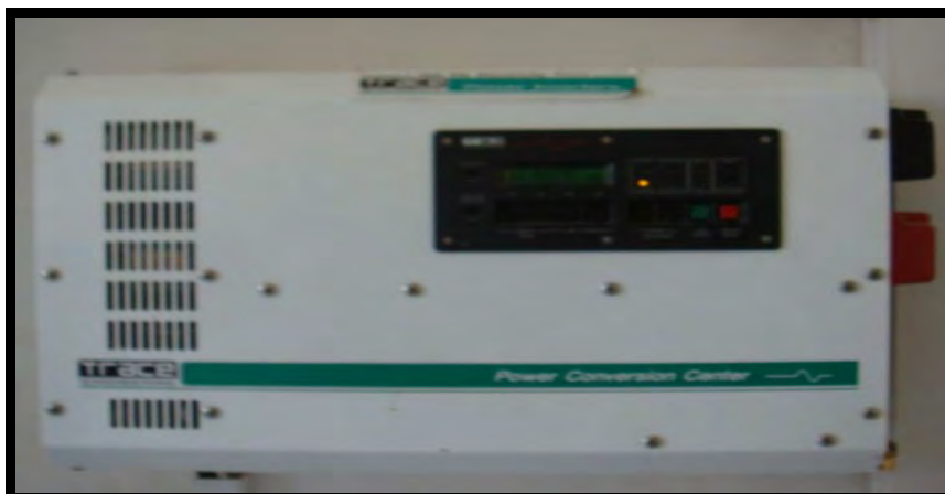
Figure (7) : Convertisseur continu alternatif du CREAR
