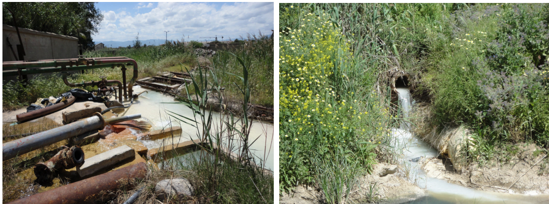
Figure 20 : caniveau d'évacuation et rejet des effluents
