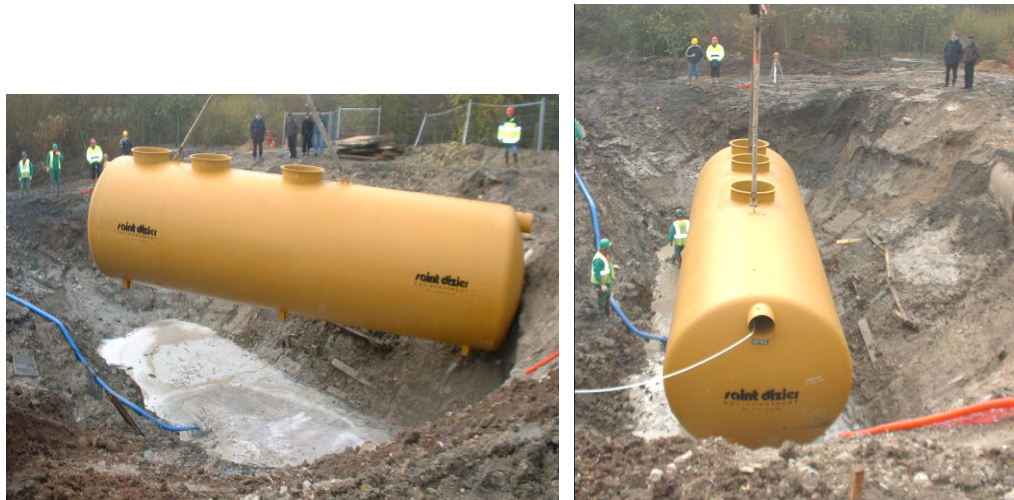
Figure 31 : Mise en place d'un déshuileur
