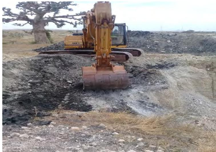
**Figure 18:** Prélèvement des sols marneux à la pelle mécanique
