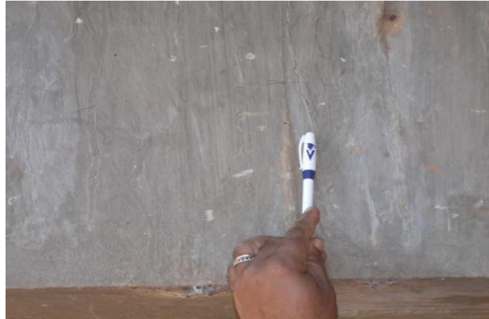
Figure 10 : Fissure de la poutre du pont Basoro, PK 33+650
