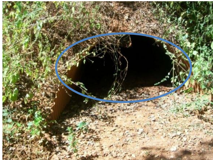
Figure 6 : Buse métallique ensablé, PK 37+501
