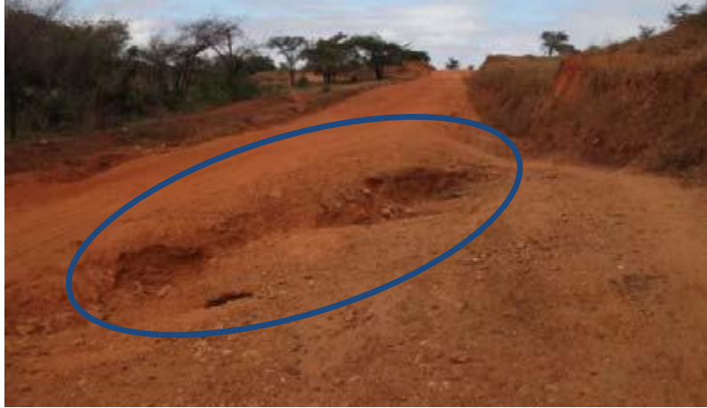
Figure 5 : Ravinement profond sur chaussée, PK 35+500
