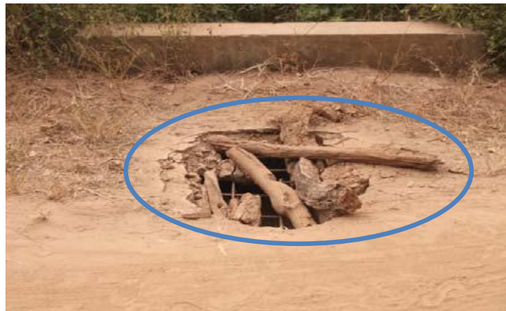
Figure 8 : Dalle de couverture de dalot ruinée, PK 33+650
