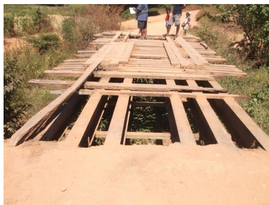
Figure 9 : Disparition des platelages et des bandes de roulement, PK 56+950
