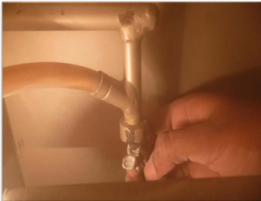
Figure 25 : Sablage du bridge
