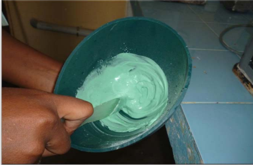
Figure 10 : Malaxage du plâtre
