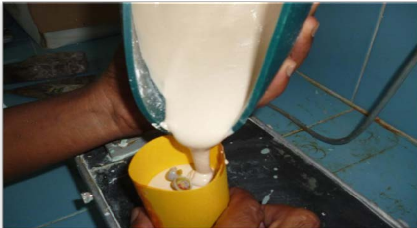
Figure 21 : Coulée de revêtement
