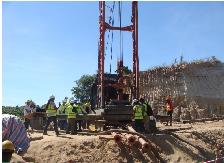
Photo 4 : Forage d'un pieu
