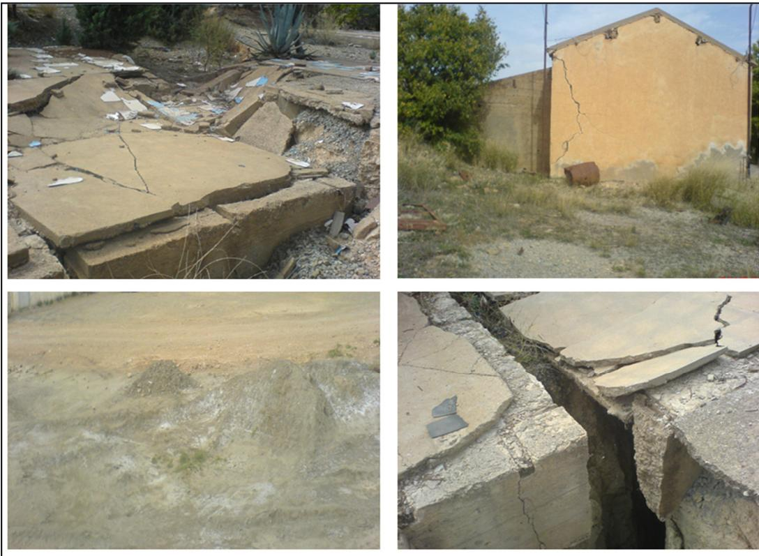
**Figure I.5 :** Observation de fractures et de fissures au-dessus des anciens travaux miniers, Mine Kherzet Youssef (BOUKELLOUL.M.L, 2007).
