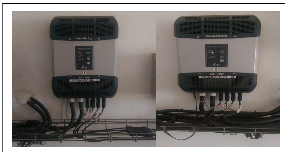
Figure 10 : Photos des Régulateurs vario string MPPT 120A-48V
