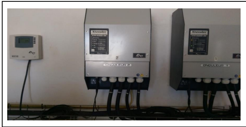
Figure 12 : Photo des Onduleur de marque « Studer »
