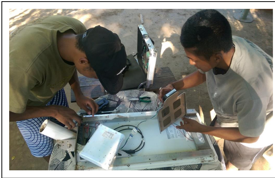
Figure 15 : Maintenance du lampadaire solaire à Ifotaka
