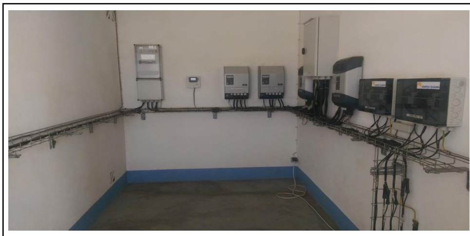
Figure 9 : Salle de matériels de régulation et de conversion
