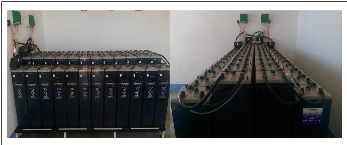
Figure 11 : Batteries HOPPECKE montées en série
