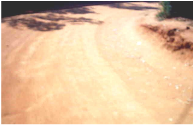
Photo 7 : Départ de matériaux, Ornière accentuée, déformation Généralisée PK : 1+00 à PK1+120
