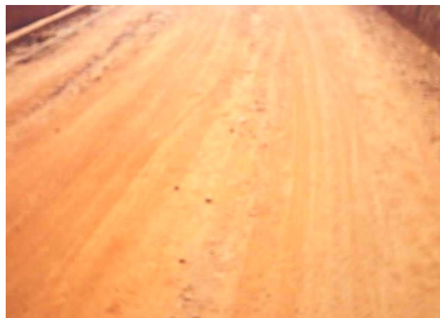
Photo 7 : Départ de matériaux, Ornière accentuée, déformation Généralisée PK : 1+00 à PK1+120
