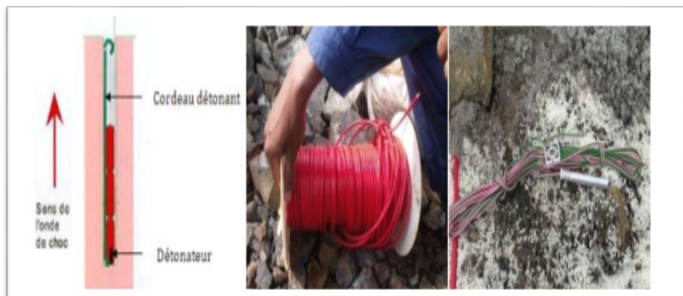
Figure 6 : De gauche à droite ; Amorçage latéral remontant -Cordeau détonant- Détonateur électrique.
