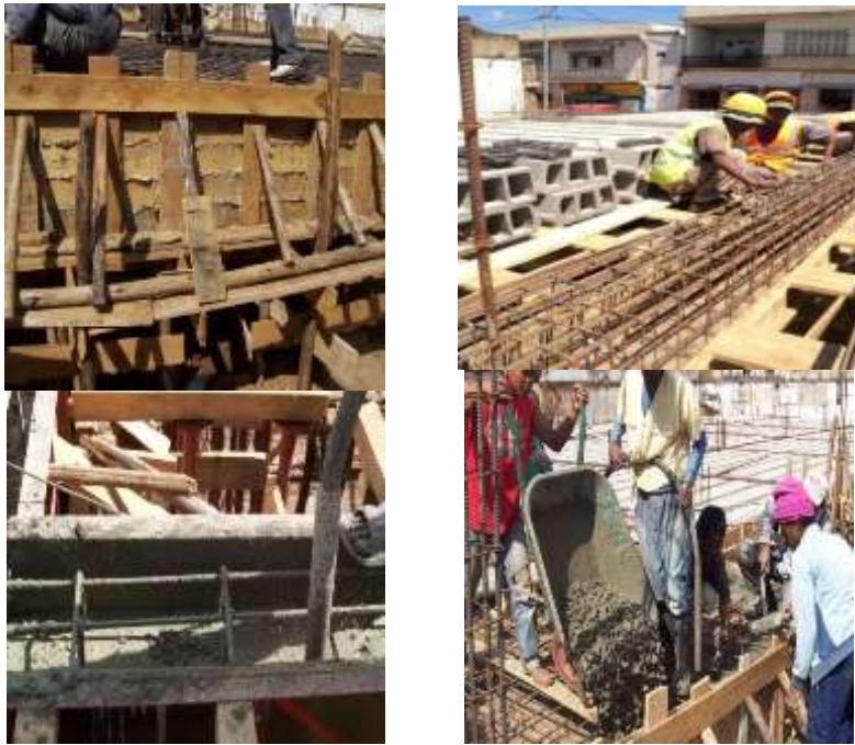
Figure 42: Mise en œuvre des poutres
