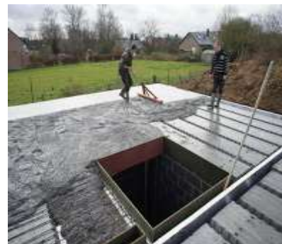
Figure 43: Mise en œuvre d'un plancher à hourdis
