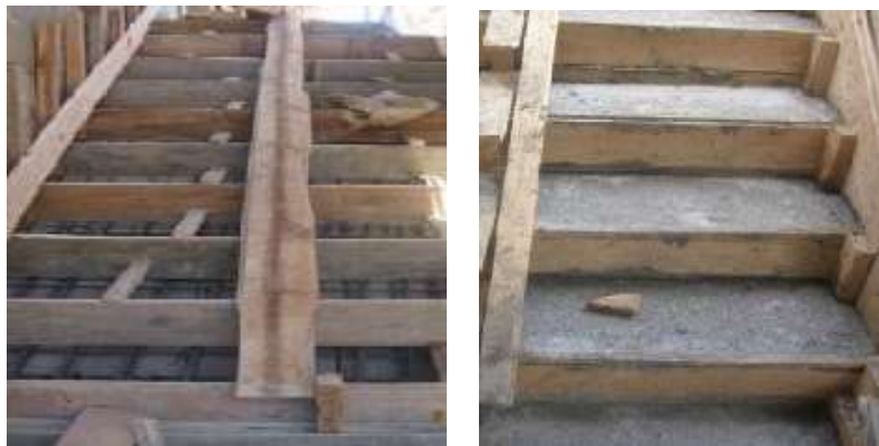
Figure 44: Mise en œuvre d'un escalier
