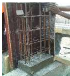
Figure 41: Mise en œuvre d'un poteau
