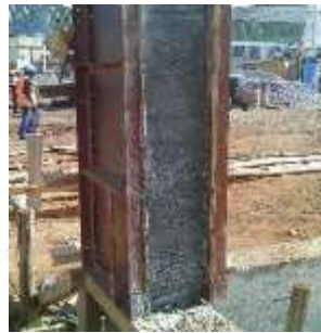
Figure 41: Mise en œuvre d'un poteau
