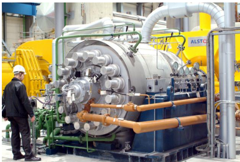
Figure 16 : Photo d'une pompe du fabricant KSB menant 2\,500\text{ t h}^{-1} d'eau à 350 bar dans une centrale à vapeur (Olivier Cleynen)
