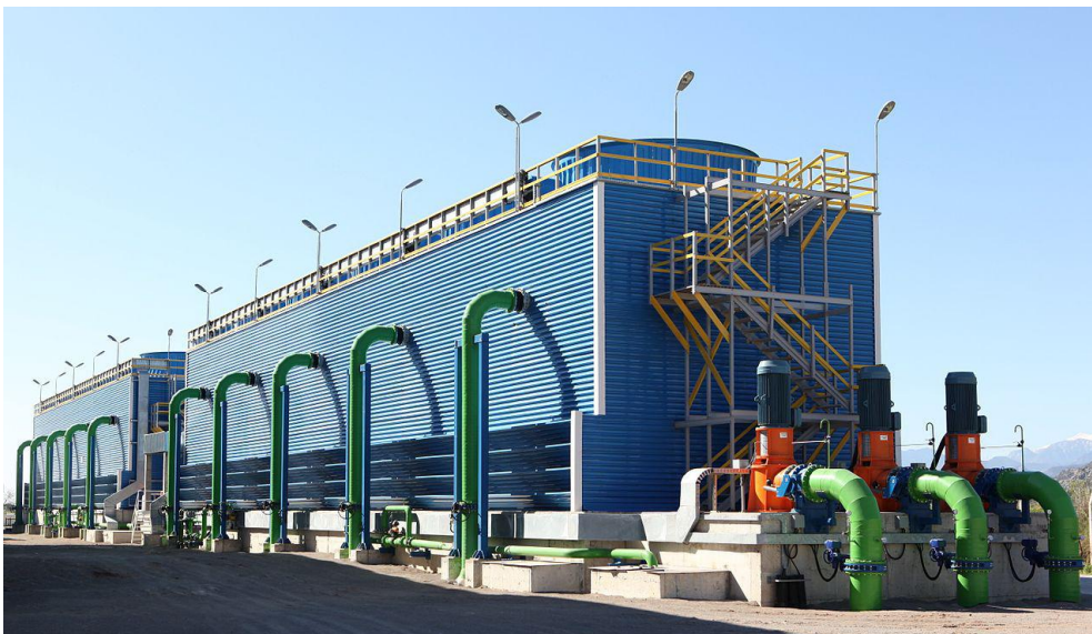
Figure 22 : Un condenseur dans lequel la chaleur est évacuée directement dans l'atmosphère, par conduction forcée à l'aide de ventilateurs (Olivier Cleynen)
