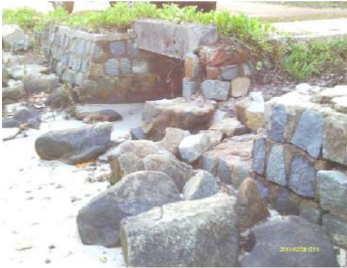
Figure 3 : Dégradation d'ouvrage de tête (mur en aile) du dalot
