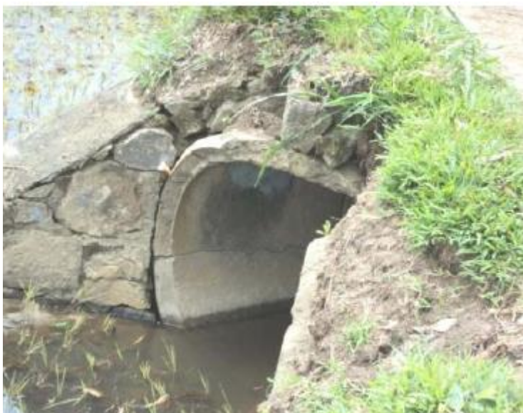
Figure 5 : Fissuration et Cassure de la buse et dégradation du mur en aile
