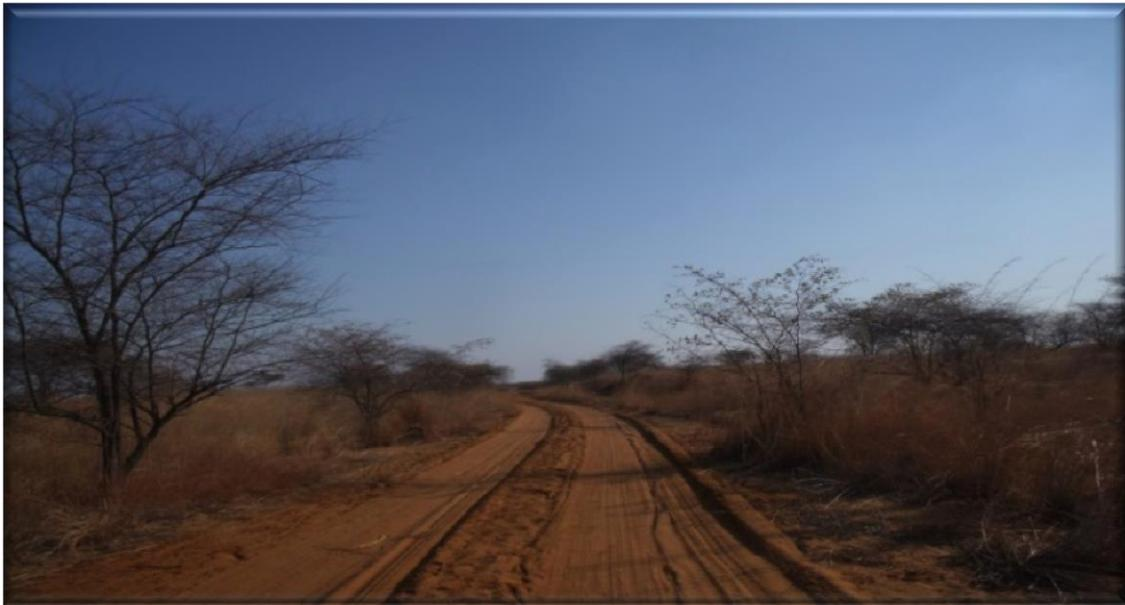
*Photo 1 : Route poussiéreuse et glissante avec absence de bombement (concave)*
