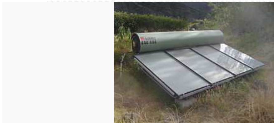
Photo6 :Chauffe-eau solaire de type monobloc : capteurs et ballon de stockage placés sur le même châssis.
