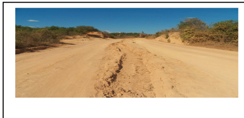
Photo 2: Ravinement Longitudinal Au RN 5A PK10+500 au PK 10+600
