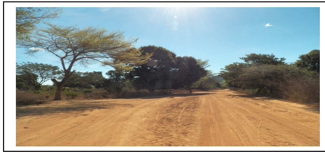
Photo 4: Profil En W Au RN 5A Pk 20+050 au Pk 20+102
