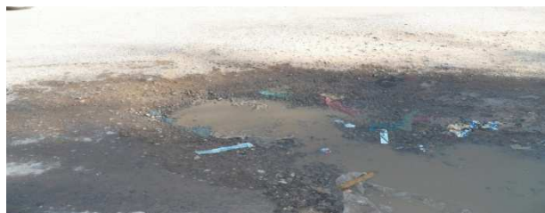
Photo 1: Nid de poule au RN 5A PK 0 + 000 au RN 5A PK 0 + 050 :
