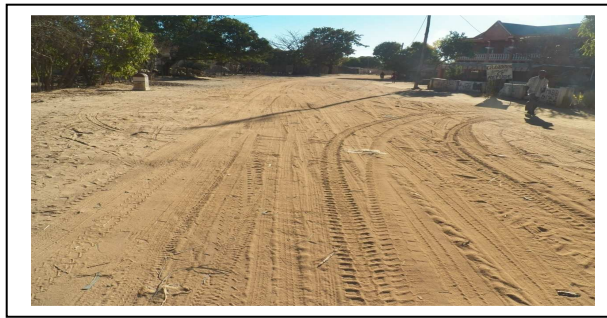
Photo 3: Ensablement Au RN 5A PK 13+100 au RN 5A PK 13+200
