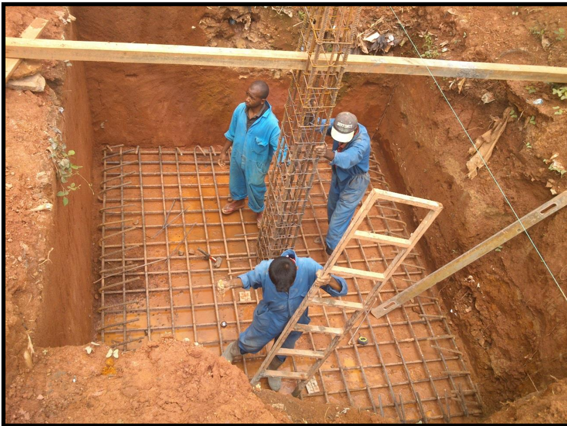
Figure 37: Mise en place des armatures
