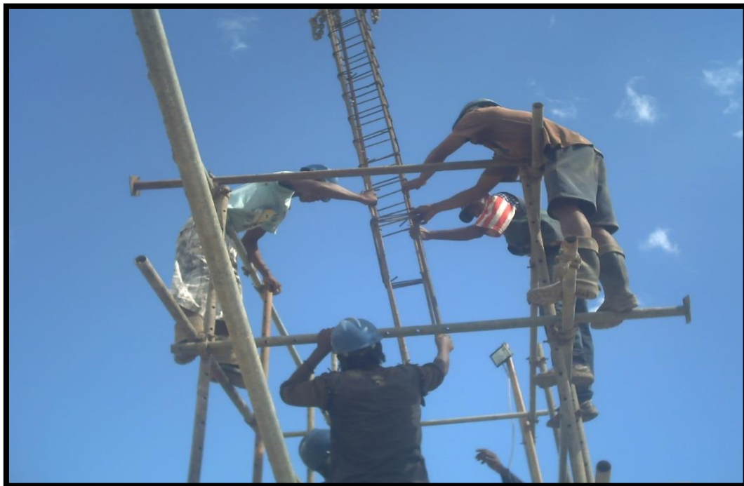
Figure 39: Mise en place le l'armature
