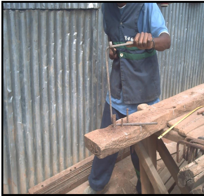
Figure 27 Façonnage des armatures
