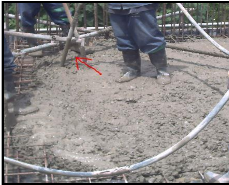
Figure 33 : Vibration par pervibrateur
