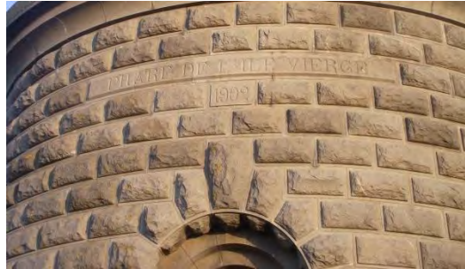
Figure 9 Moellons de bossage sur l'entrée principale du phare
