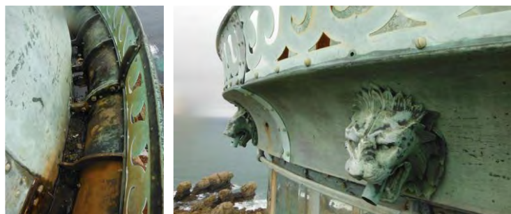
Figure 11 Chéneau et gargouilles de la lanterne. Vue extérieure [6].
