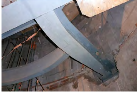
Figure 18 Poutres métalliques du plancher de la chambre de service. Encastrement après décapage - Photo CEREMA
