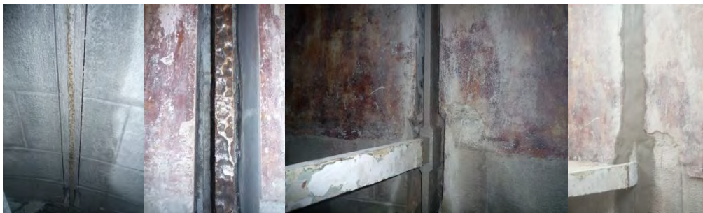
Figure 17 Réparation des montants de la lanterne au niveau de soubassement. Les quatre phases de chantier : sciage, mise à nu des montants, peinture, pose de nouveau mortier de rebouchage – Photos CEREMA
