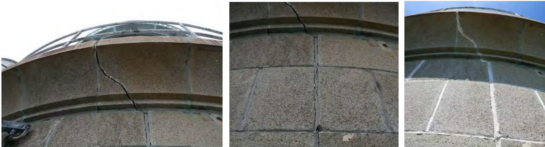
Figure 13 Fissure du montant n° 3 au soubassement de la lanterne a) Partie supérieure – juin 2011 b) Rejointoiement en mauvais état - juin 2011 – Photos CEREMA. c) Rejointoiement en silicone – juin 2017 – Photo N. Domède
