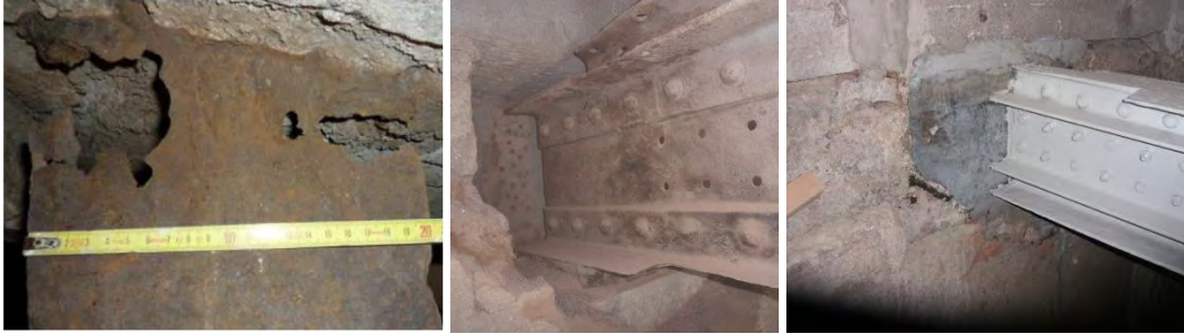
Figure 19 Poutres métalliques du plancher de la chambre de lanterne. Encastrement avant, durant et après réparation – Photo CEREMA
