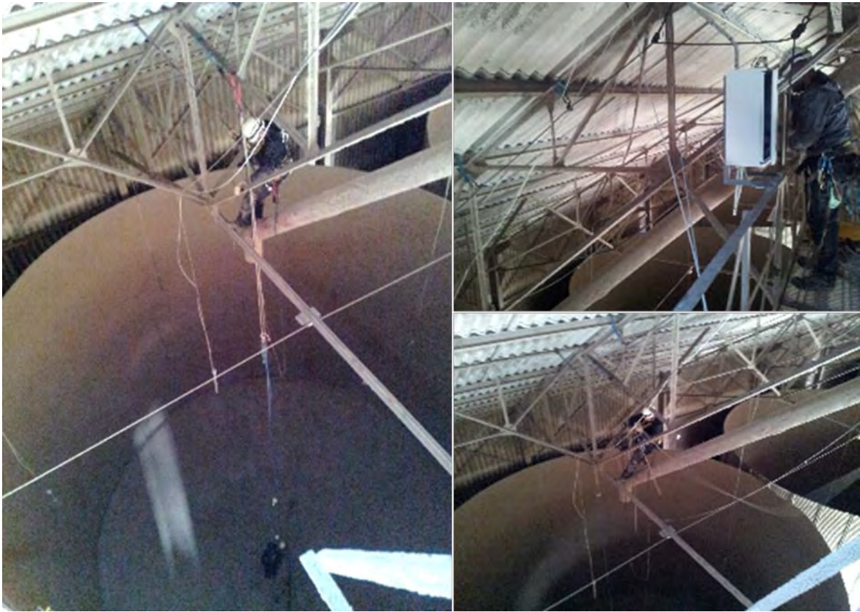
Figure 77 : Installation de la sonde SILOTEST 3
