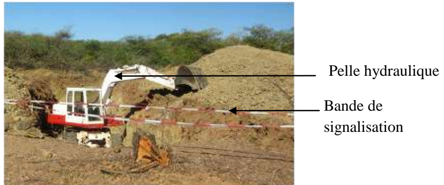
Figure 1 : Bande de signalisation autour d'une tranchée
