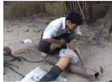
Photo n°10 :Fermeture de l'ouverture du tube d'entrée avec un sac plastique
