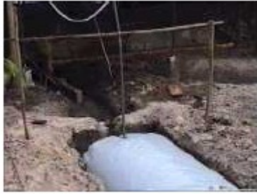
Photo n°19 : le conduit est relié au digesteur
