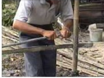
Photo n°17 : Connexion du tuyau de distribution du gaz au support
