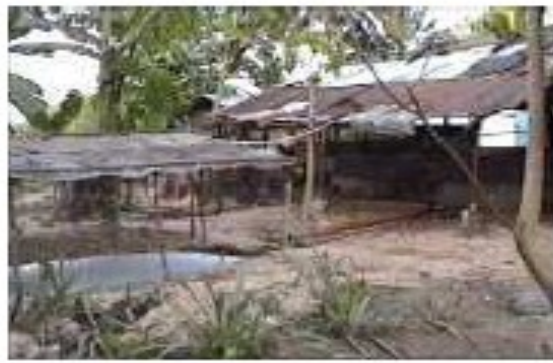
Photo n°21 : le système complet : un toi peu protéger le biodigesteur des rayons UV
