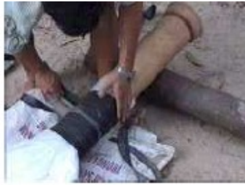
Photo n°9 : Enroulement du caoutchou autour du plastique pour le fixer au tube
