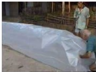
Photo n°12 : Le digesteur rempli d'air
