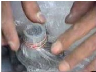
Photo n°10 :Fermeture de l'ouverture du tube d'entrée avec un sac plastique
