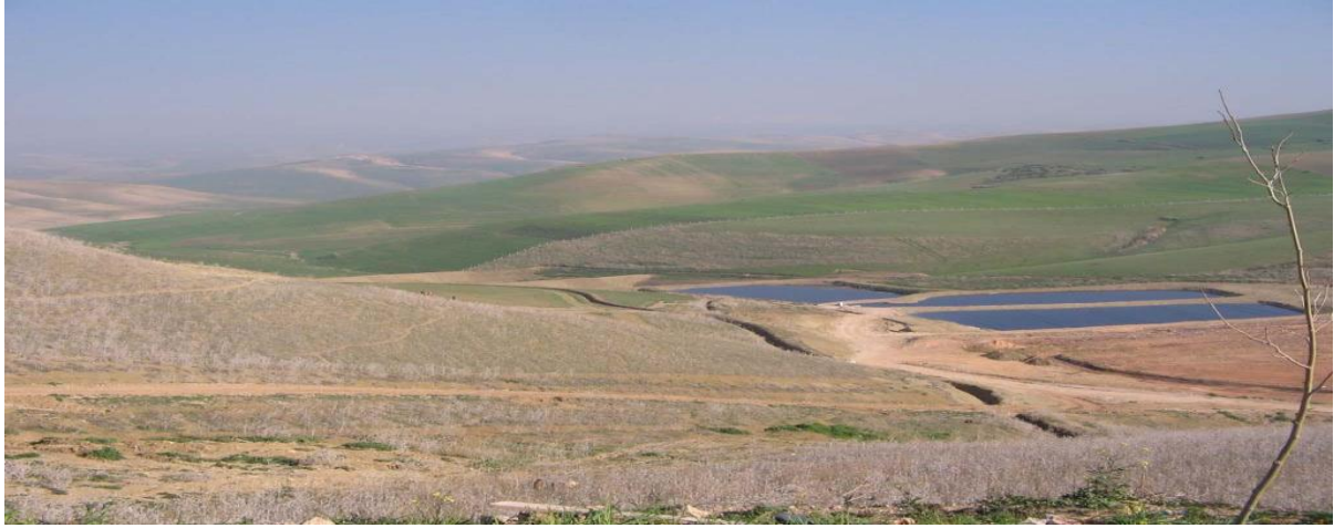
Photo 2 : Bassins de stockage des lixiviats de la décharge contrôlée publique de Fès
