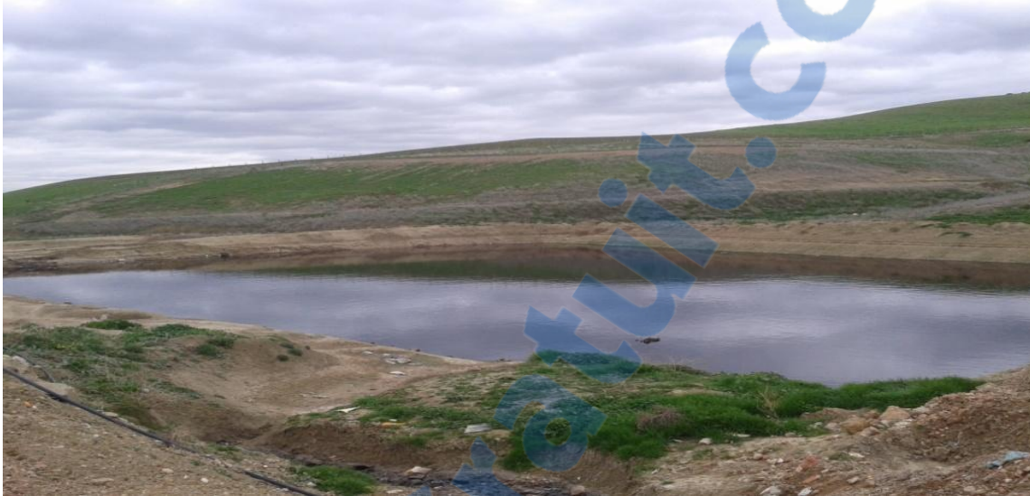
Photo 12 : Bassins de stockage des lixiviats
