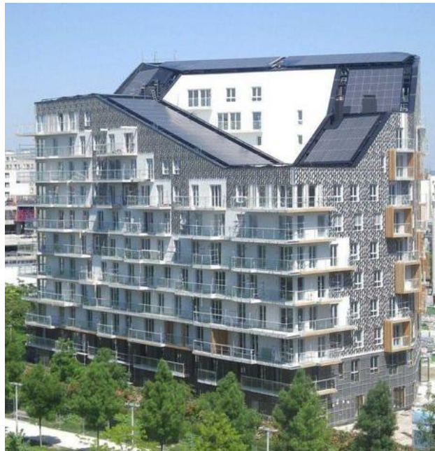
Figure 36. L'immeuble Quintessence de Nexity et sa centrale solaire gérée par Solarvip (Source: Pouthier, 2012)
