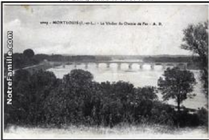
Illustration 8 : Viaduc du chemin de fer à Montlouis-sur-Loire
