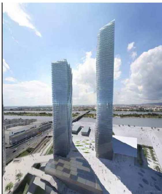
Figure 73: STRABAG Haus , Maison des Arts, de la Transparence et de l'Innovation du projet Centrope
