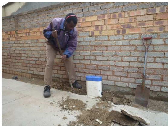
Illustration 21 – Etape 2 : déterrer le compteur
