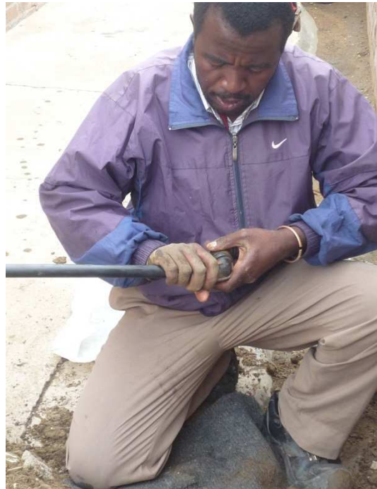
Illustration 25 – Etape 4 : Fabrication artisanale d'un conduit de remplacement
