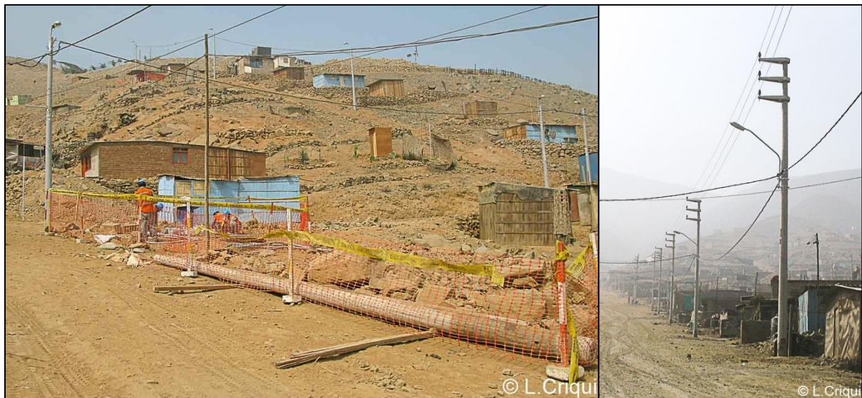
Photo 97/L. Électrification avant construction complète
