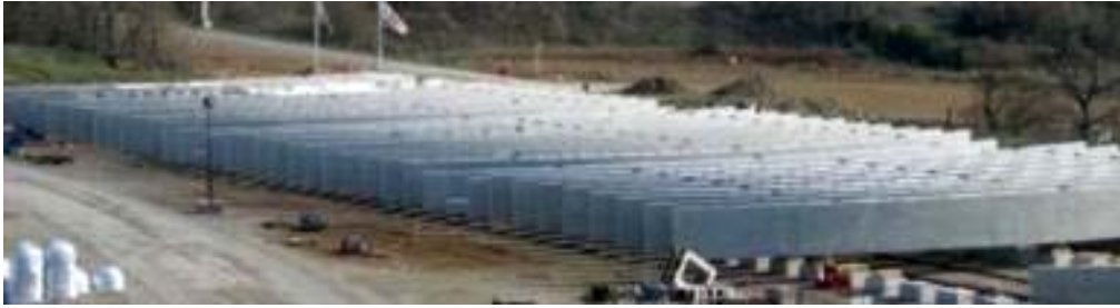
Figure 1.22. Barrière du péage du pont Millau (53 voussoirs – 2300 tonnes de BSI® 2005)
