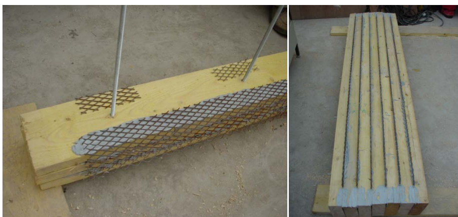
Figure 1.28. Connexion en métal déployé [De Noray, 2005]
