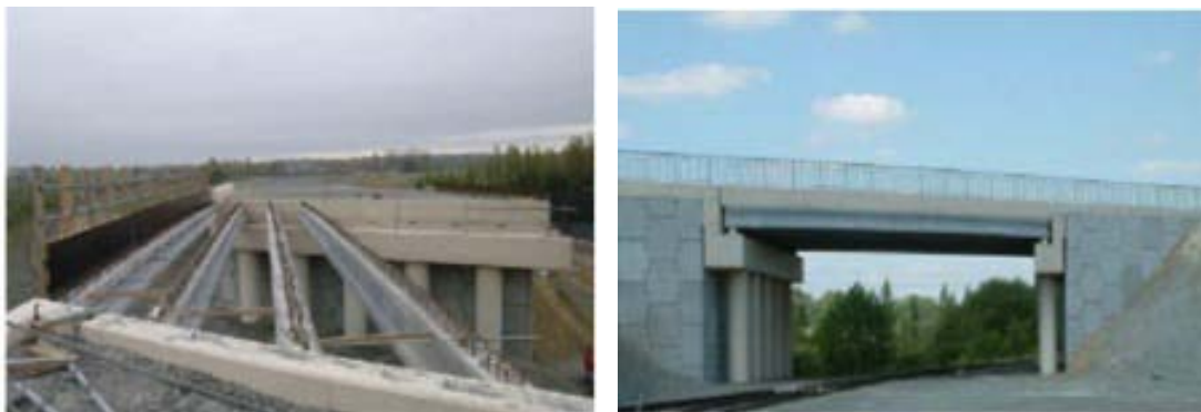
Figure 1.24. Pont de Saint Pierre la Cour, Mayenne (2005 - Ductal® 2005)
