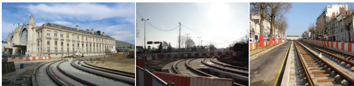
Figure 30 : Travaux du tramway (gare, Monconseil, Tranchée) (Réalisation personnelle)
