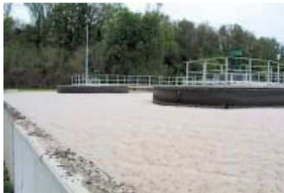
Figure 3 : Mousse biologique en surface de bassin d'aération (d'après Document technique FNDAE N° 33)
