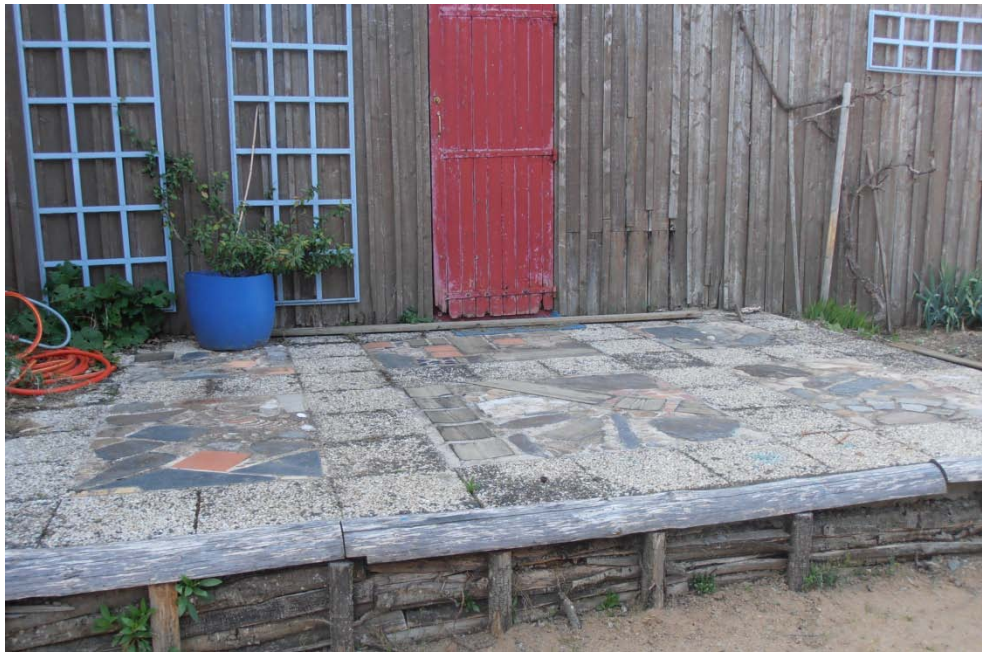
Figure 36 : Terrasse construite par les habitants d'Habitat Différent, mars 2012, CD
