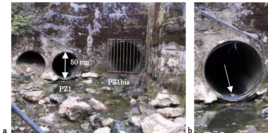
Planche 3 : vues du collecteur "PZ1" (deuxième en partant de la gauche), depuis le fond du fossé, dos tourné vers l'aval. Le collecteur visible à sa gauche est entièrement bouché et ne rejette rien. Le deuxième collecteur actif "PZ1bis", muni d'une grille, est visible à sa droite. Sur l'agrandissement de droite (b), on distingue la sonde de mesure de vitesse et de pression au bas du collecteur (voir 2.1.2), sous la flèche.
