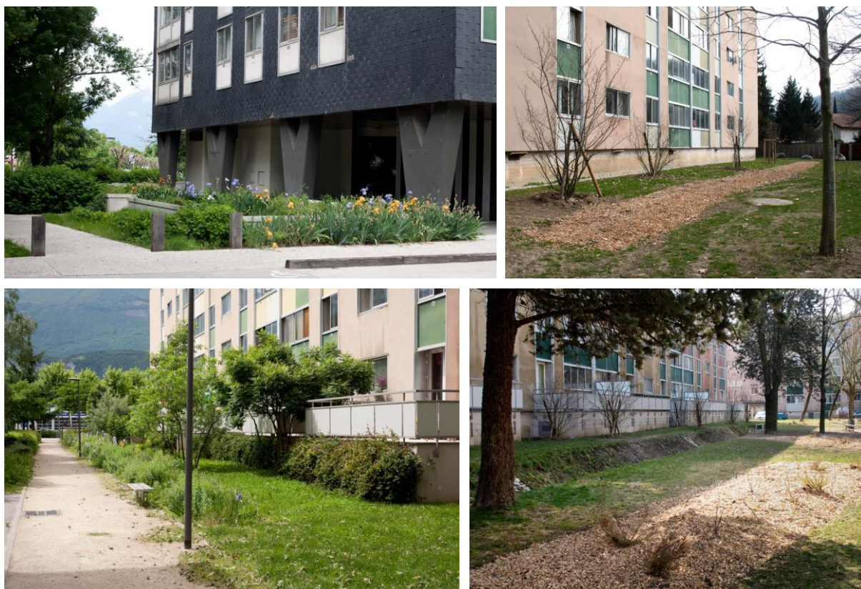
Aménagements en pieds d'immeubles. Une convergence des objectifs esthétiques, écologiques et de normalisation des usages : noues, tranchées drainantes et massifs arborés ou fleuris. Photos L. Morand
