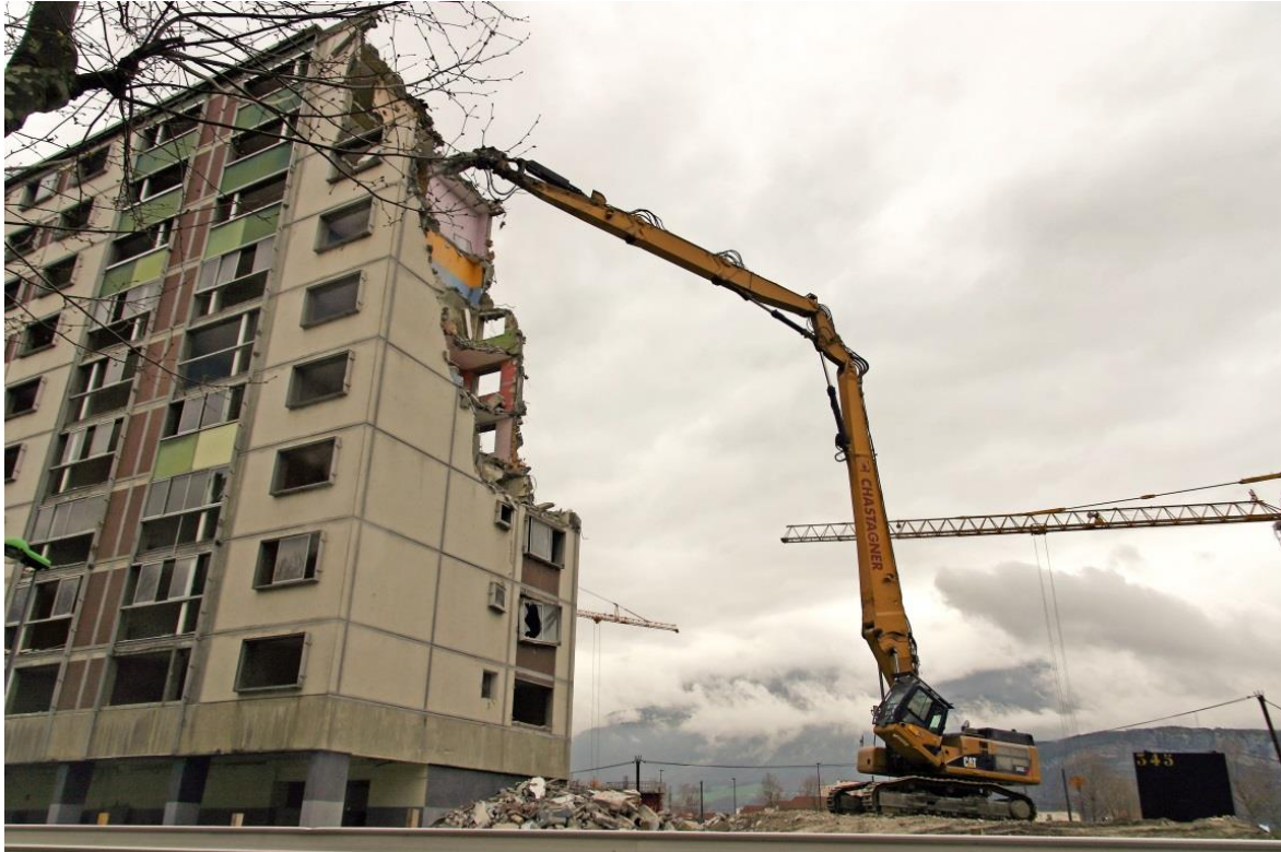
Démolition par grignotage, Village 2. Collection Didier Collignon (habitant)
