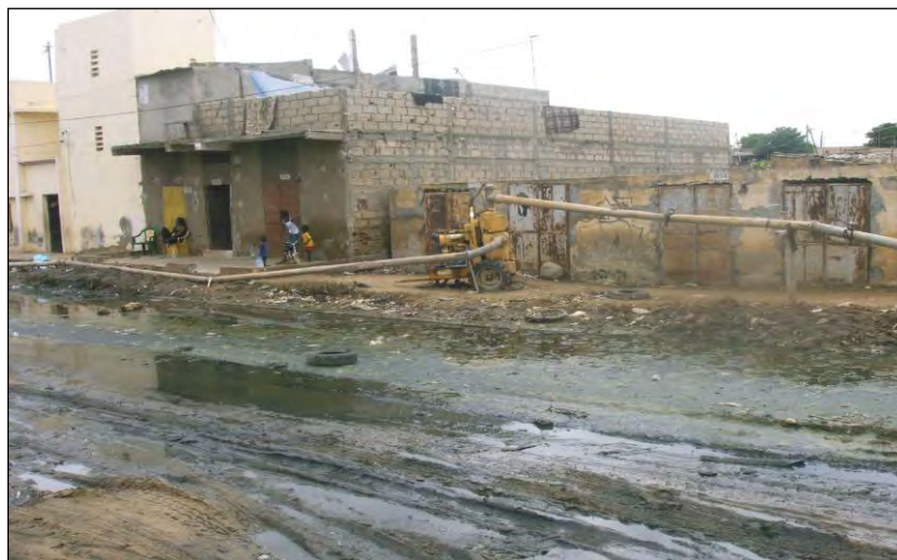
Figure12: Opération de pompage des eaux à Gounass 1
