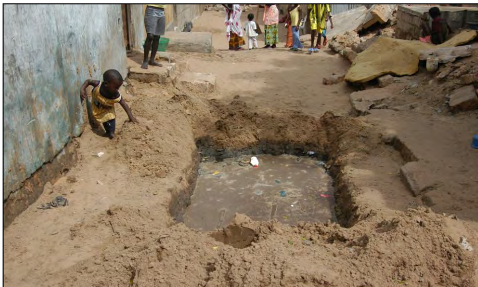
Figure5 : Evacuation des eaux vannes à Gounass2 bis
