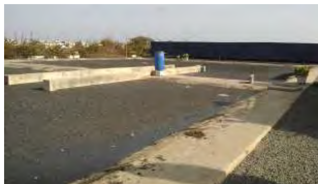
Photo 4: Bassins anaérobies (crédit photo Youssoupha Coly, 2018)
