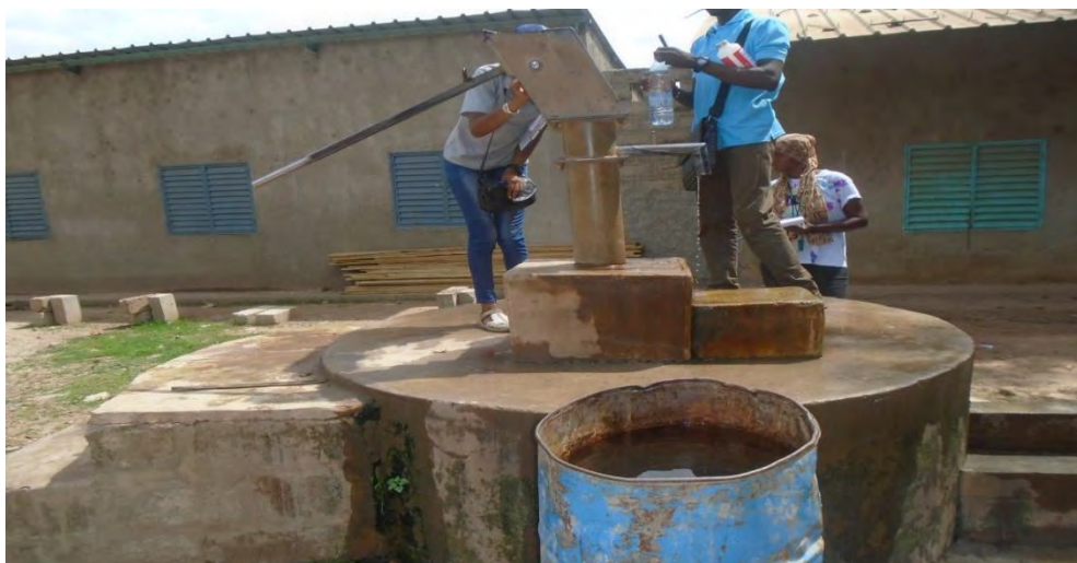
Photo 12 : Puits équipé de pompe manuelle à Mansacounda dans la commune de Tanaff
