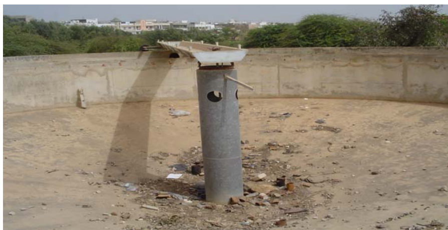
Photo 2 : Image d'un décanteur
