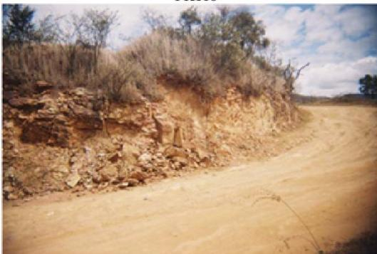
**Figure 4:** Courbe de faible rayon avec pente élevée du profil en long
