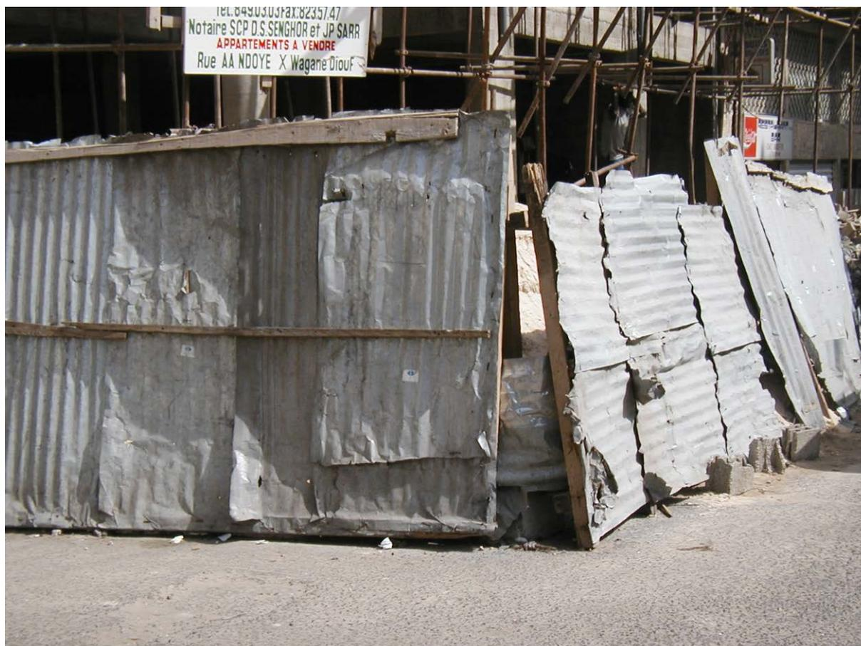
**Fig. 9 : Clôture de chantier**
