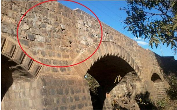
**Figure 20** : Dégradation de la maçonnerie
