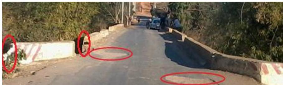
**Figure 22** : Guide-roue et plots endommagés et chaussée détériorée
