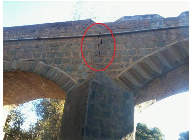
**Figure 21** : Fissures observées
