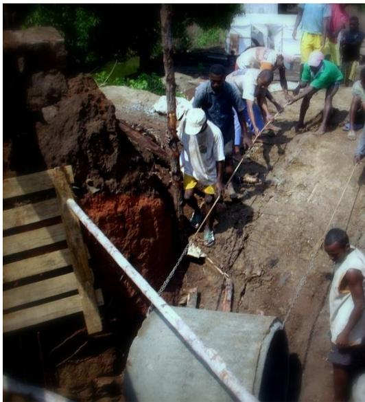
**Figure 55 :** Introduction de la buse en béton
