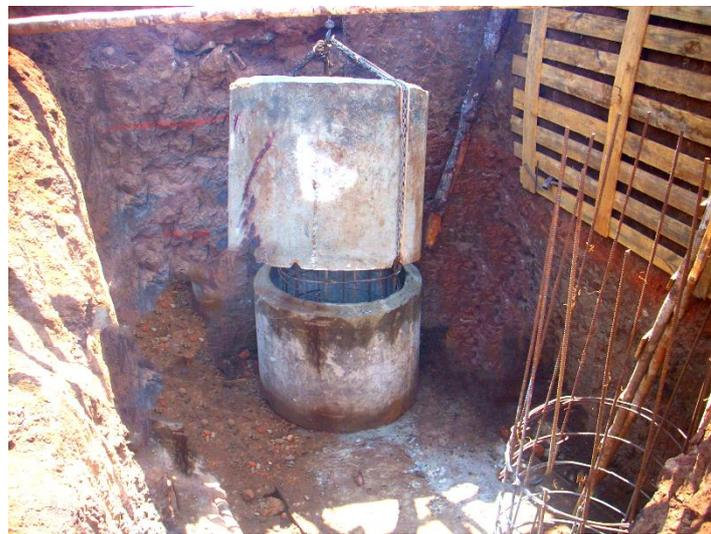
**Figure 60** : Montage de la colonne de fondation
