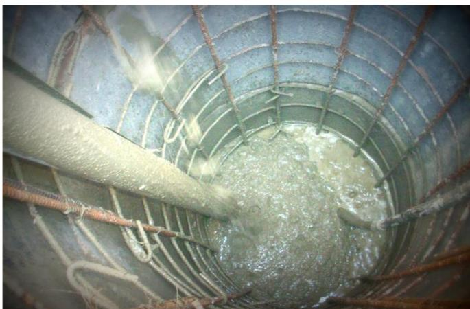
**Figure 57 :** Intérieure d'un pieu pendant coulage
