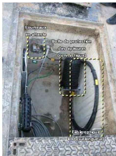
Figure 40 : STRUCTURE D'UNE CHAMBRE DE TIRAGE [W12]
