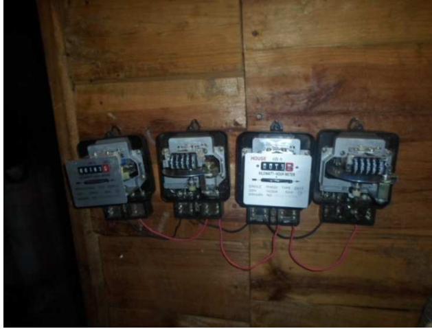
Figure 13 : montage des compteurs en série
