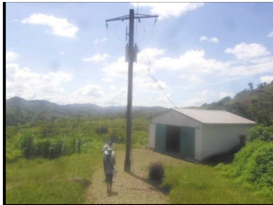
Figure 7 : bâtiment de la centrale de Tolongoïna
