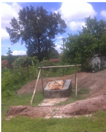
Photo 10 : Puits en pleine rénovation
