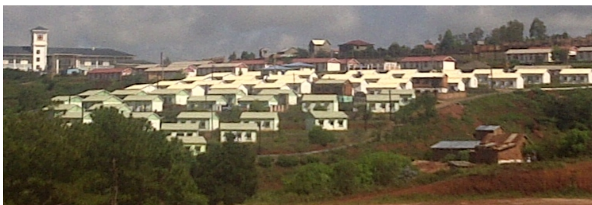
Photo 8 : Vue panoramique planifiée des logements sociaux
