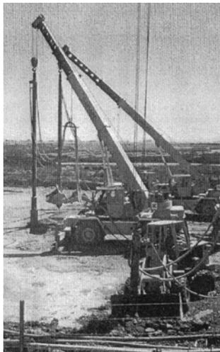
La technique consiste à descendre dans le sol un vibreur manipulé par une grue, qui sous son propre poids, et sous l'influence d'un lançage d'eau et des vibrations, atteint les profondeurs souhaitées. Ensuite, **dans la cavité ainsi créée dans le sol incohérent, mise en place de matériau d'apport sable ou gravier, sans retrait de sol.** L'opération est répétée selon un maillage prédéfini
