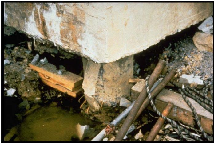
*Pieu dénudé sous l'effet d'un phénomène de liquéfaction. A hauteur du niveau d'eau on voit qu'en outre les aciers longitudinaux ont flambé sous l'effet d'un effort en compression (Séisme de Kobé, 1995) (Document EQIIS – USA)*
