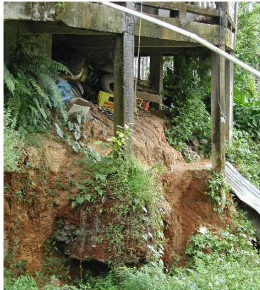
*La fondation d'un bâtiment en zone sismique demande la maîtrise du comportement du sol et des fondations à proprement parler. Ici les semelles isolées et le sol instable sont un exemple de double facteur aggravant la vulnérabilité des superstructures en zone sismique (Document P. Balandier).*
