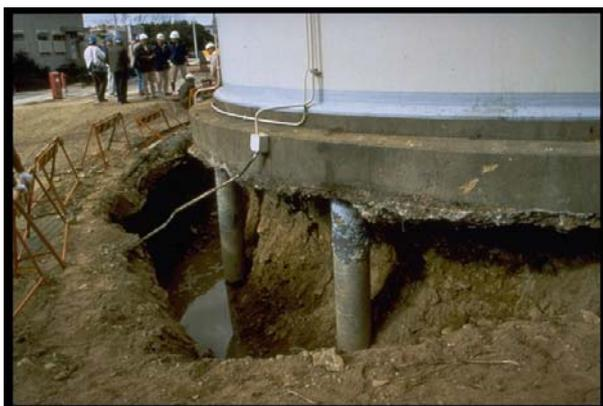
**A gauche** - Tassement du sol sous l'effet d'un phénomène de liquéfaction. La présence de fondations descendues au bon sol a permis d'éviter à la citerne de basculer. Néanmoins, le type de liaison entre les têtes de
